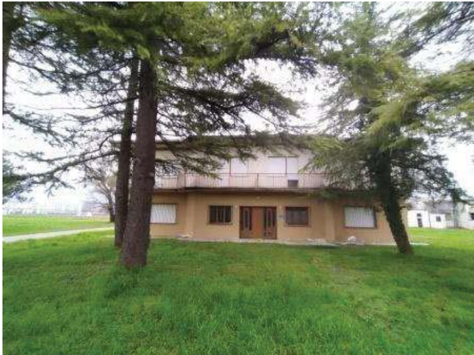
fronte Sud (A)
